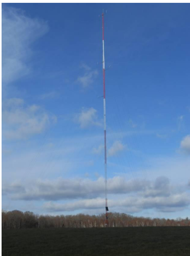
Photographie du mât installé sur site
